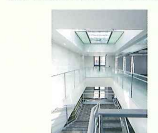
トップライト採光部(13.6m²) 広拡散採光装置(2.6m²)
