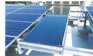
太陽光発電(多結晶シリコン:22.68kW) 太陽熱集熱器(15.6kWh/日)
