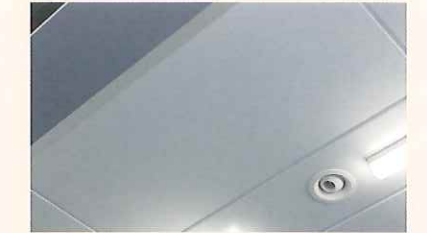
放射パネル(冷房40W/枚、暖房140W/枚×216枚) パーソナル空調(30m³/h)
